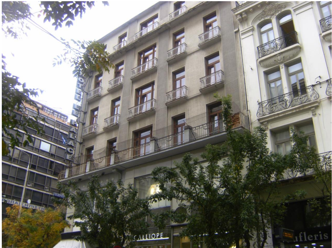
Εικόνα 2 Πρόσοψη επί της οδού Τσιμισκή 12 και Ελ. Βενιζέλου
